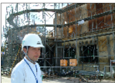
現場はヘルメット着用です。
