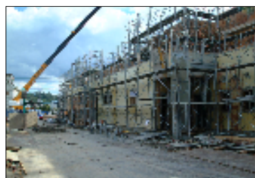
工事はかなり進んでいる様子です。
