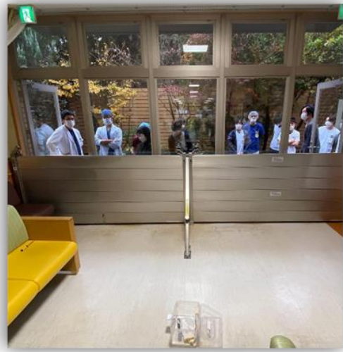
bcp(冠水対策)としての止水版設置訓練の様子
